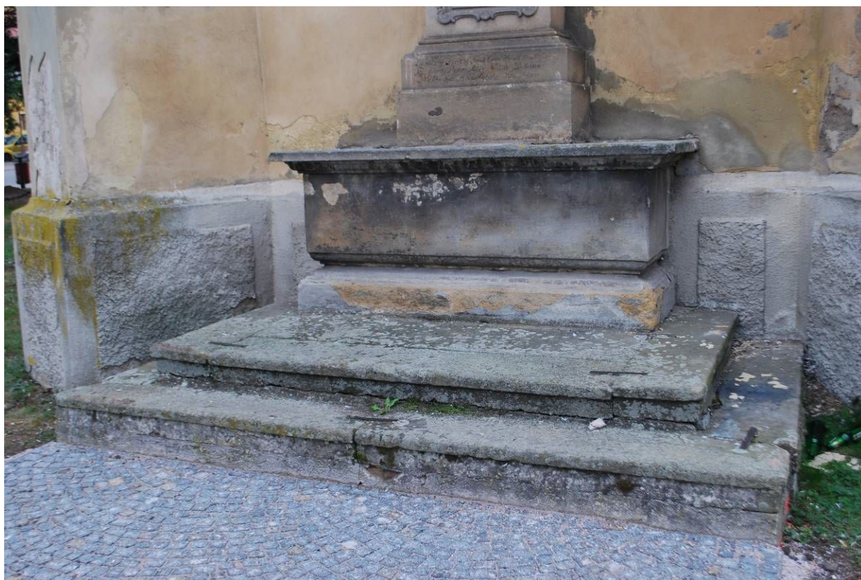
Silné poškození dvou řady stupňů, napadení mechy a lišejníky
